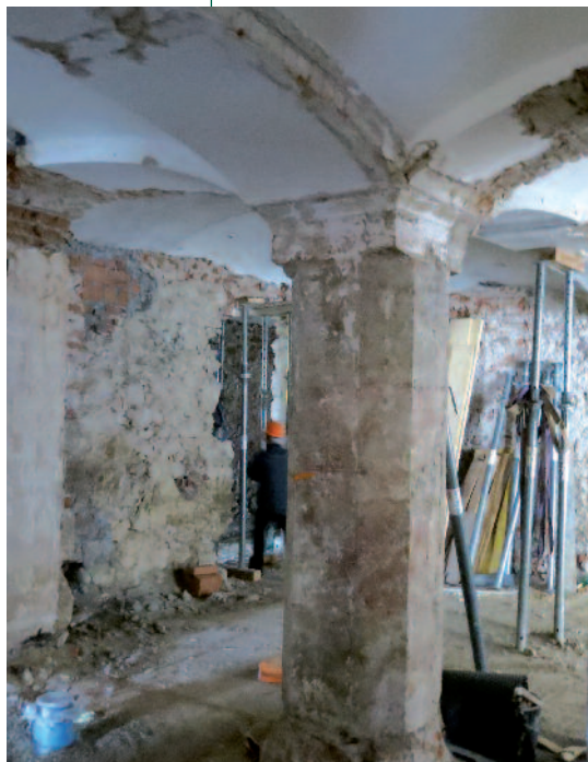
Baudetail im Verwaltungstrakt, Freilegung des alten Gewölbes im Kellerbereich
