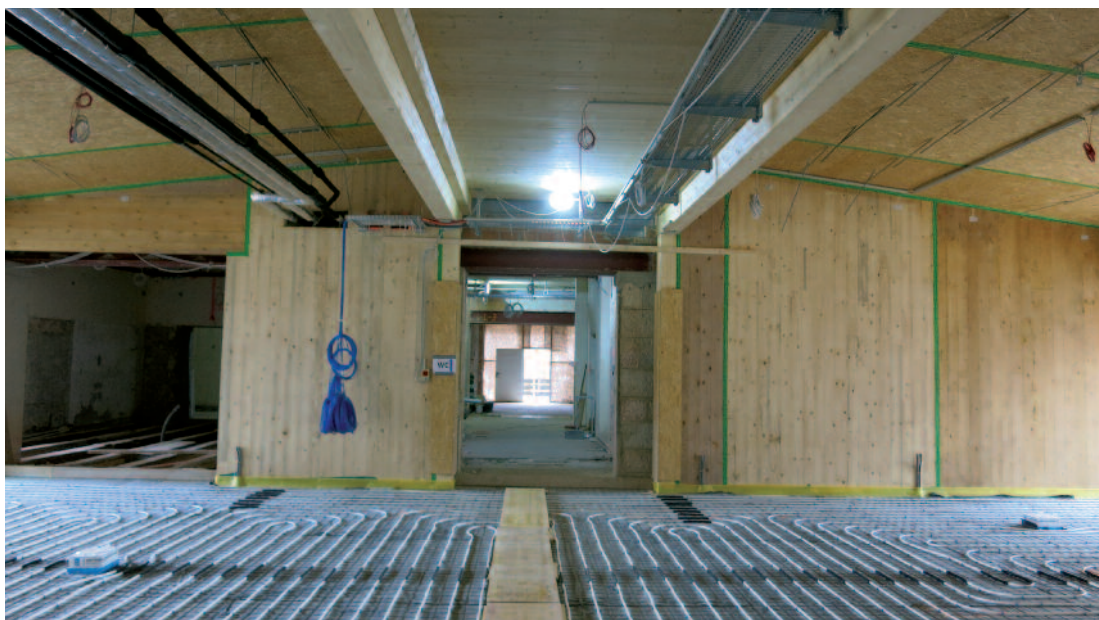
Verlegung der Fussbodenheizung März 2018
