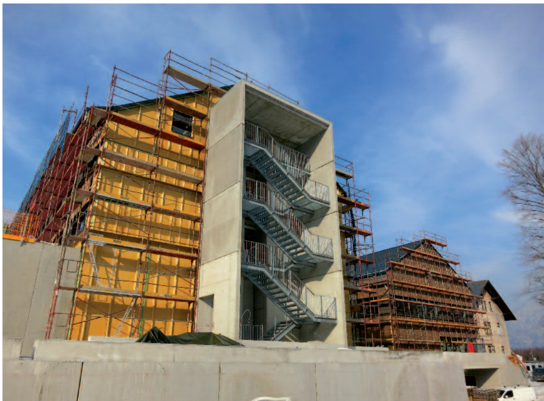
Das Fluchtstiegenhaus im Mai 2018
