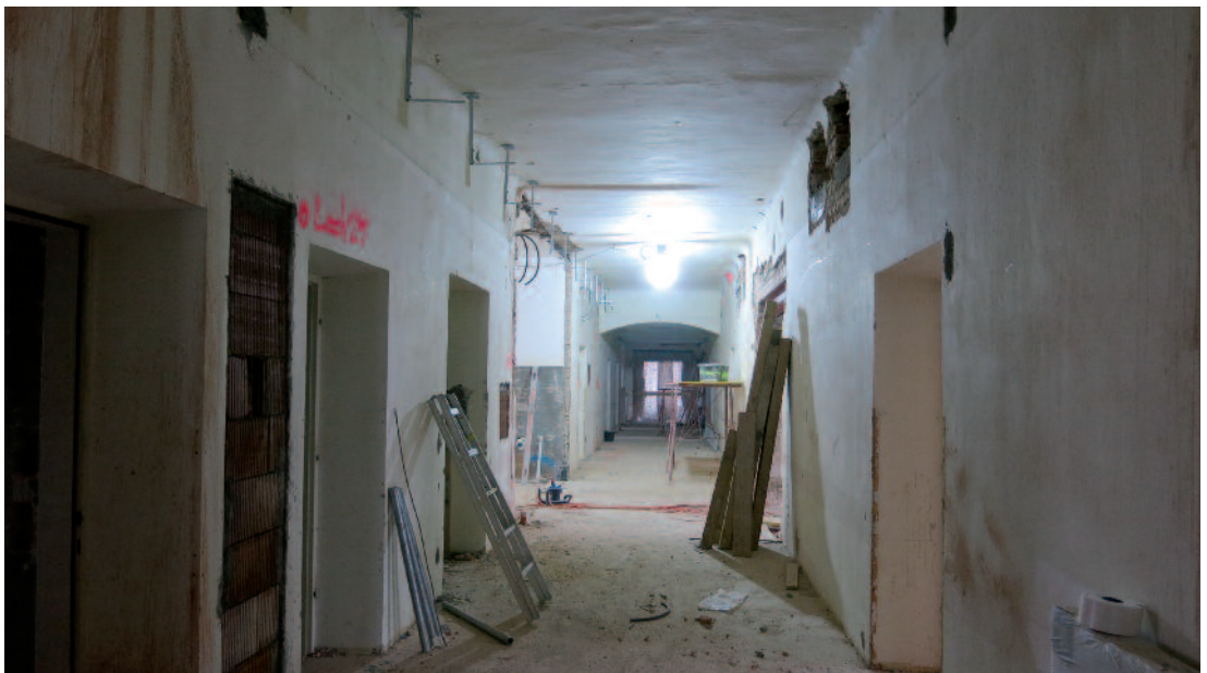
Kellergeschoß während der Renovierungsphase Februar 2018
