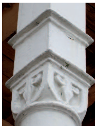
Kapitäl der Eisenkonstruktion des Balkons
