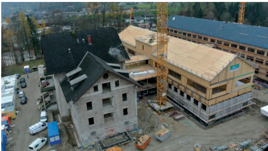
Baustelle von oben am 16. November 2017
