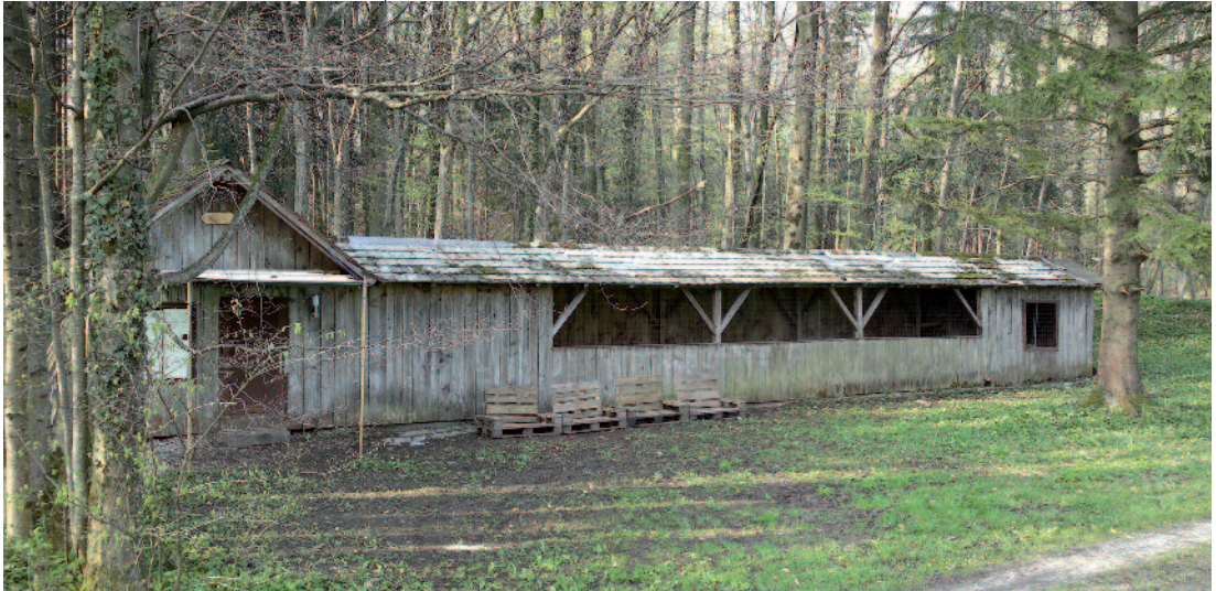
Ehemalige Kegelspielanlage am Areal des FBZ Traunkirchen
