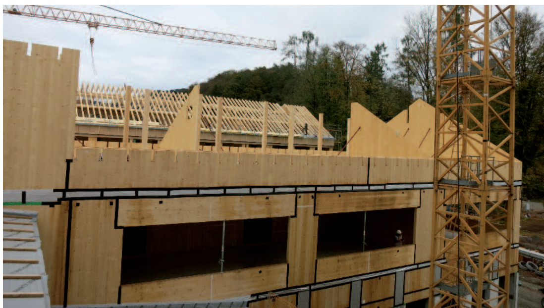
Ausführung des Schulungstraktes in konstruktivem Holzbau
